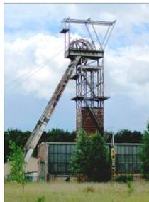
ehemaliger Schacht der Wismut AG mit Maschinenhaus mit 6 Sohlen, Trommelfördermaschine, Fördergerüst und Maschinenpark, in den Jahren 1970 – 1972 errichtet, bis 1991 als Material- und Watterschacht genutzt
