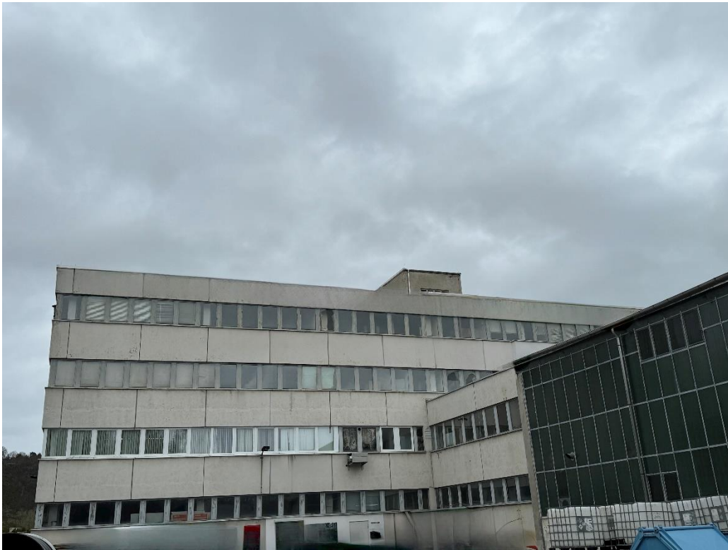
Südwestseite mit angrenzender Werk-/Lagerhalle
