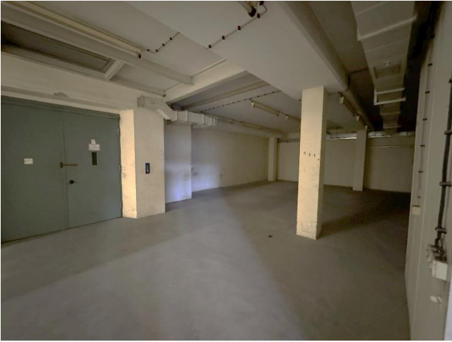
Mittlerer Geschossbereich mit Zugang zum Aufzug
