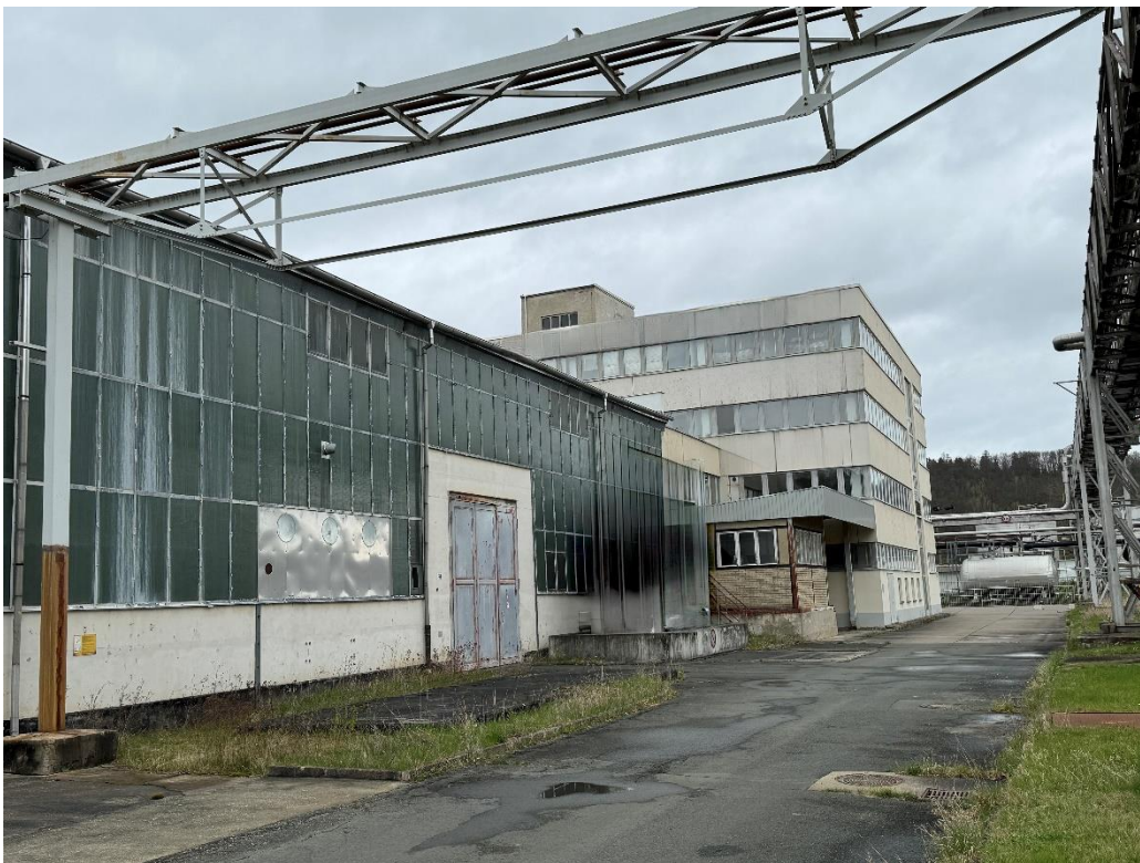
Südostseite mit angrenzender Werk-/Lagerhalle
