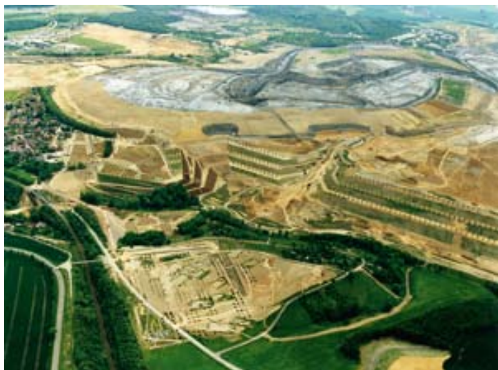
Blick auf den neu entstehenden Aufschüttkörper Lichtenberg mit vorgelagerter Kernzone der „Neuen Landschaft Ronneburg“, in der 2007 die Bundesgartenschau stattfand Quelle: Archiv Wismut 26.5.2005
