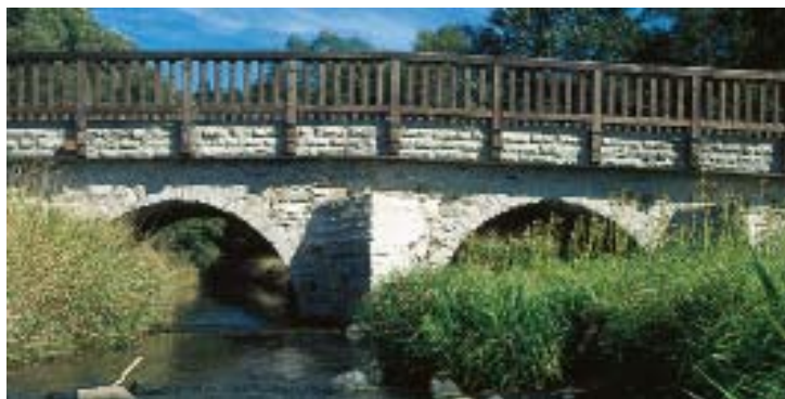
Denkmalgeschützte Steinbogenbrücke bei Läwitz
