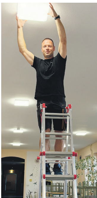
Hausmeister Daniel Bauer beim Anbringen der neuen Beleuchtung in der Regelschule Berga.
