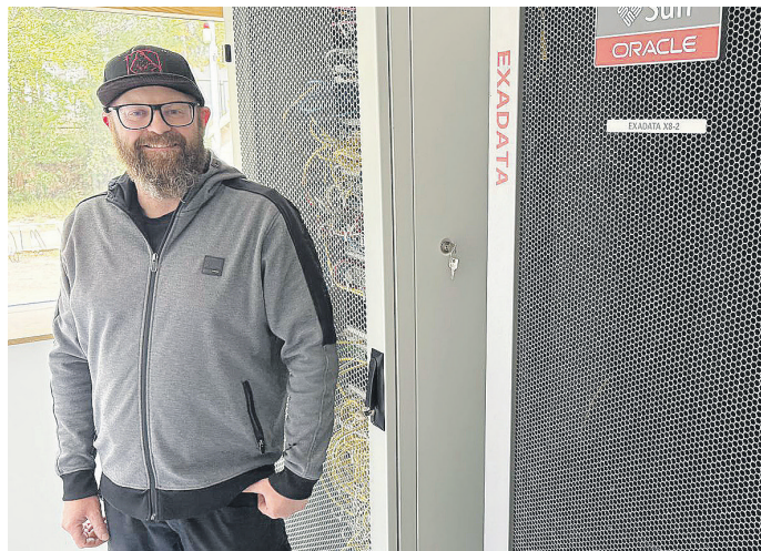
Hausmeister Tino Kaufmann im neuen Serverraum der Grund- und Regelschule Greiz-Pohlitz. (Fotos: Landratsamt/Uwe Müller)
