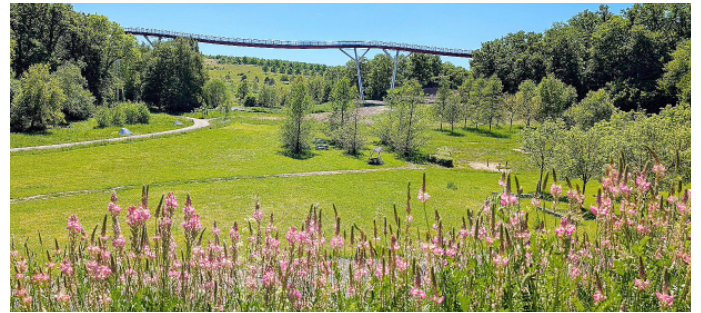
Das Gessental mit der sanierten Drachenschwanzbrücke.
