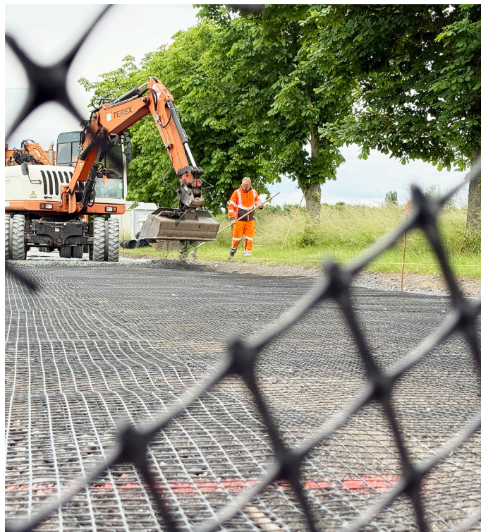
Straßenbau zwischen Mückern und Großenstein. Das Geogitter wird eingebaut.
