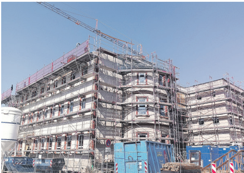
Schulbaustelle Bad Köstritz.
