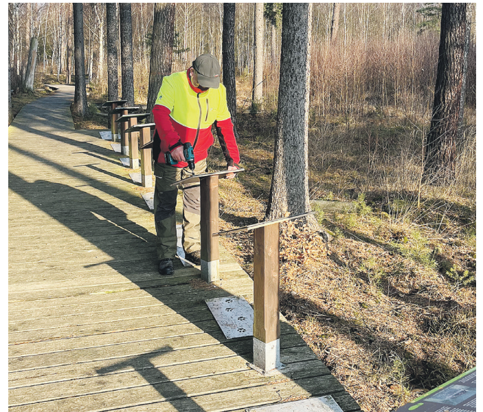
Ein Mitarbeiter des Bundesforsts installiert die neuen Schilder entlang des Moorerlebnispfades. (Foto: Bundesforst/Jörn Krüger)
