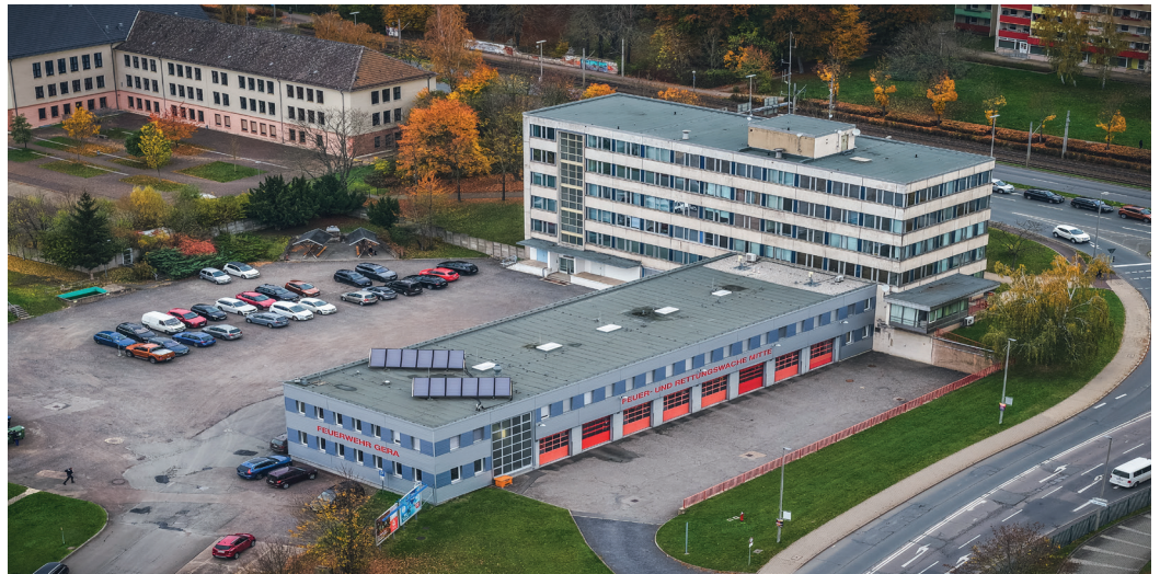
Blick auf die Feuer- und Rettungsleitwache Gera-Mitte.
