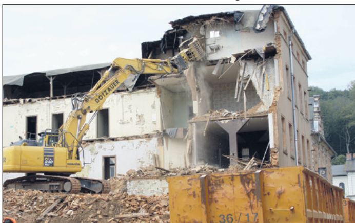
Mehr als drei Jahre hat es gedauert, ehe für die maroden Gebäude Thüringer Hof und Bahnhofstraße 2 in Greiz eine Lösung erreicht wurde, die letztlich Abriss hieß. Der Weg bis zu diesem Ergebnis erwies sich für Behörden wie für Anlieger als wahrer Stresstest.
