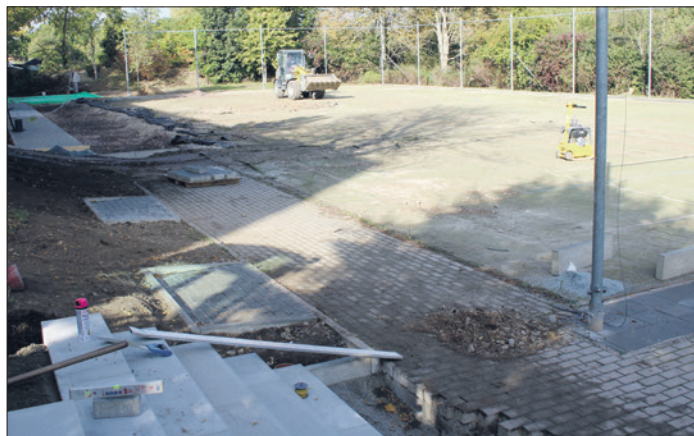
Aktuell laufen noch die Arbeiten an der Sportanlage am Osterlandgymnasium in Gera. Bis Jahresende sollen sie abgeschlossen sein.
