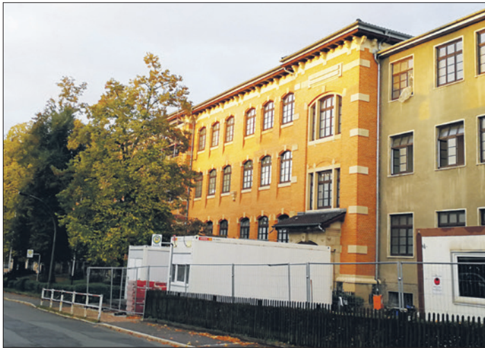
Die denkmalgeschützte Klinkerfassade der Regelschule Ronneburg ist bereits saniert, in diesem Jahr gehen die Arbeiten weiter.
