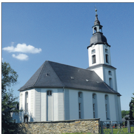
Die Döhlener Kirche mit sanierter Fassade und restaurierter Turmuhr.
