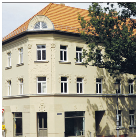
Das Haus Kirchberg 8 in Weida wurde vor dem Verfall gerettet und denkmalgerecht gesichert.
