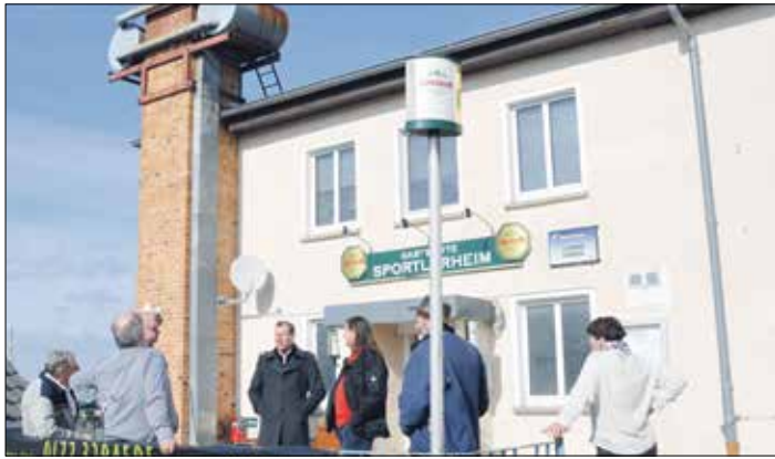
Die Turnhalle Münchenbernsdorf mit ihren Anbauten bedarf einer grundhaften Sanierung, aus dem LEADER-Programm sollen insgesamt 150.000 Euro fließen. (Fotos: RAG)
