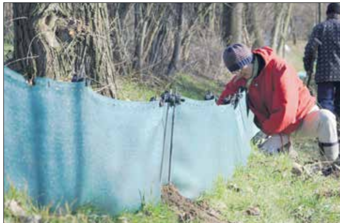
Amphibienzaunbau bei Hirschfeld aus der Froschperspektive.
