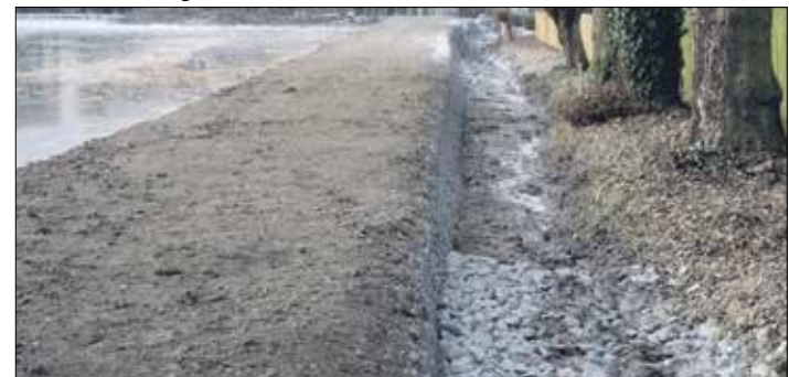
Der Damm am Schwarzbachteich nach der Fertigstellung. Die Grassaat erfolgt im Frühjahr.
