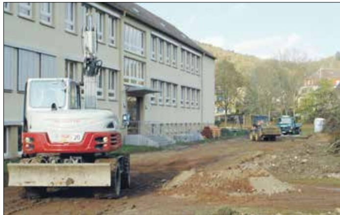
Die Außensportanlagen für die Bergaer Grund- und Regelschulen werden derzeit saniert. (Foto: Heinze/Büro Schramm)
