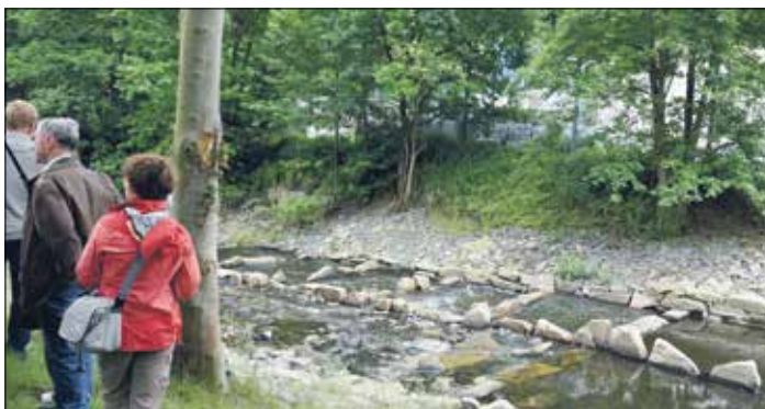
Aufstiegshilfen für Fische wurden durch die Köhler GmbH in Greiz nach dem 2013er Hochwasser in der Göltzsch neu geschaffen.
