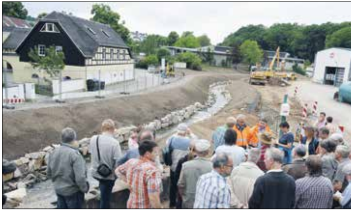
Hochwasserschutz: In Greiz läuft gegenwärtig der naturnahe Ausbau des Aubaches. (Text / Fotos: Christian Freund)
