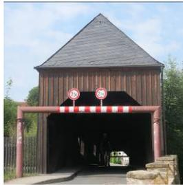
1786 anstelle einer mittelalterlichen Anlage errichtet; Holzkonstruktion auf Steinpfeilern mit seitlicher Verschalung und Überdachung von ca. 71 m Länge
